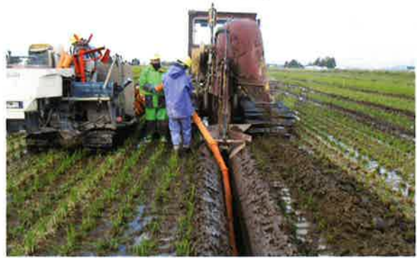
地下灌漑配管及び真奈子施工
