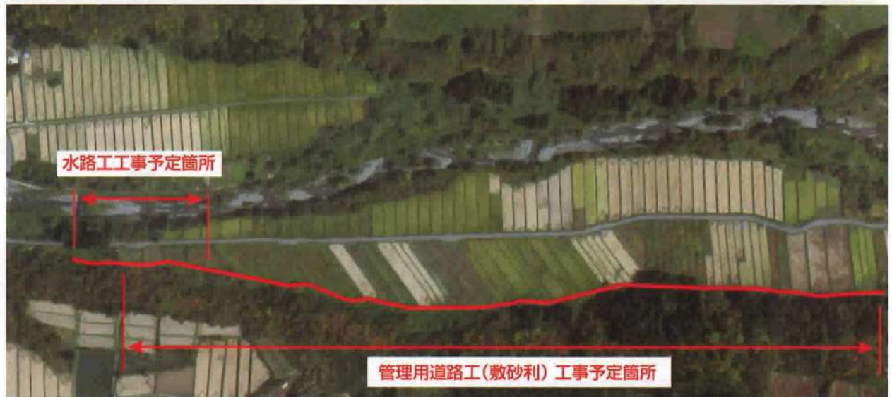
水路工及び管理用道路工(敷砂利)工事予定箇所
