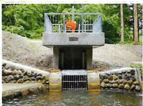
上野1号頭首工(隧道)
